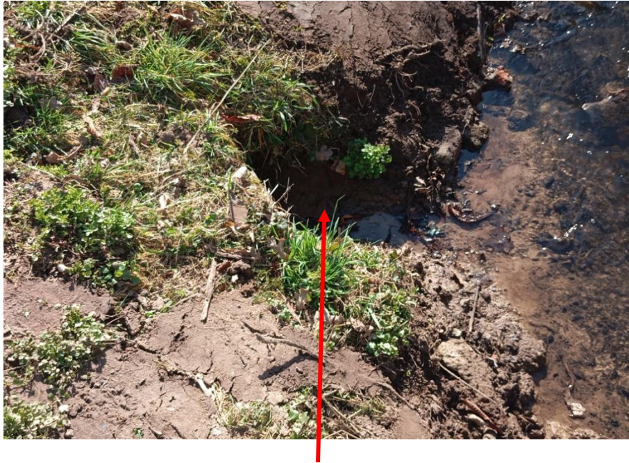
Einleitungsstelle 1 in den „Mosbach“
