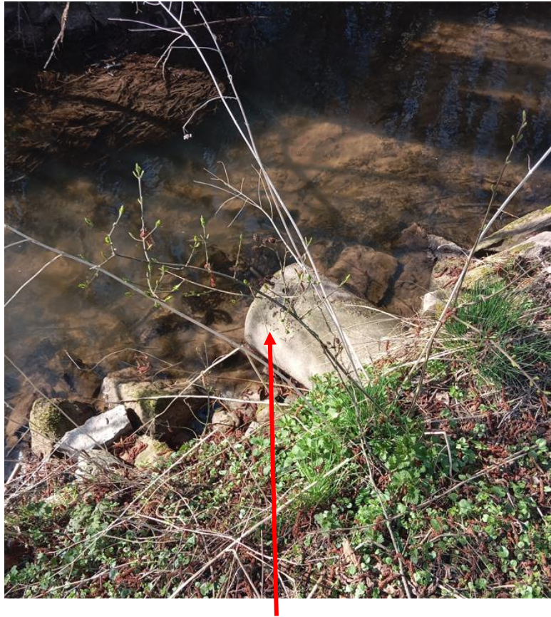
Einleitungsstelle 3 in die „Mittlere Aurach“
