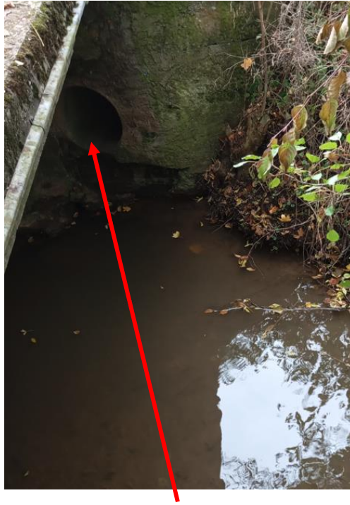
Einleitungsstelle 4 in die „Mittlere Aurach“
