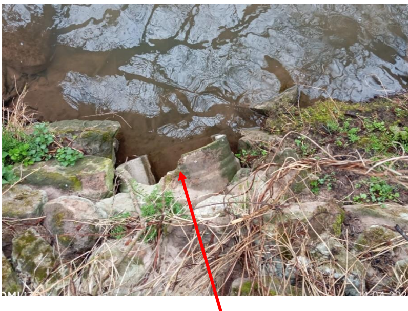
Einleitungsstelle in die „Mittlere Aurach“
